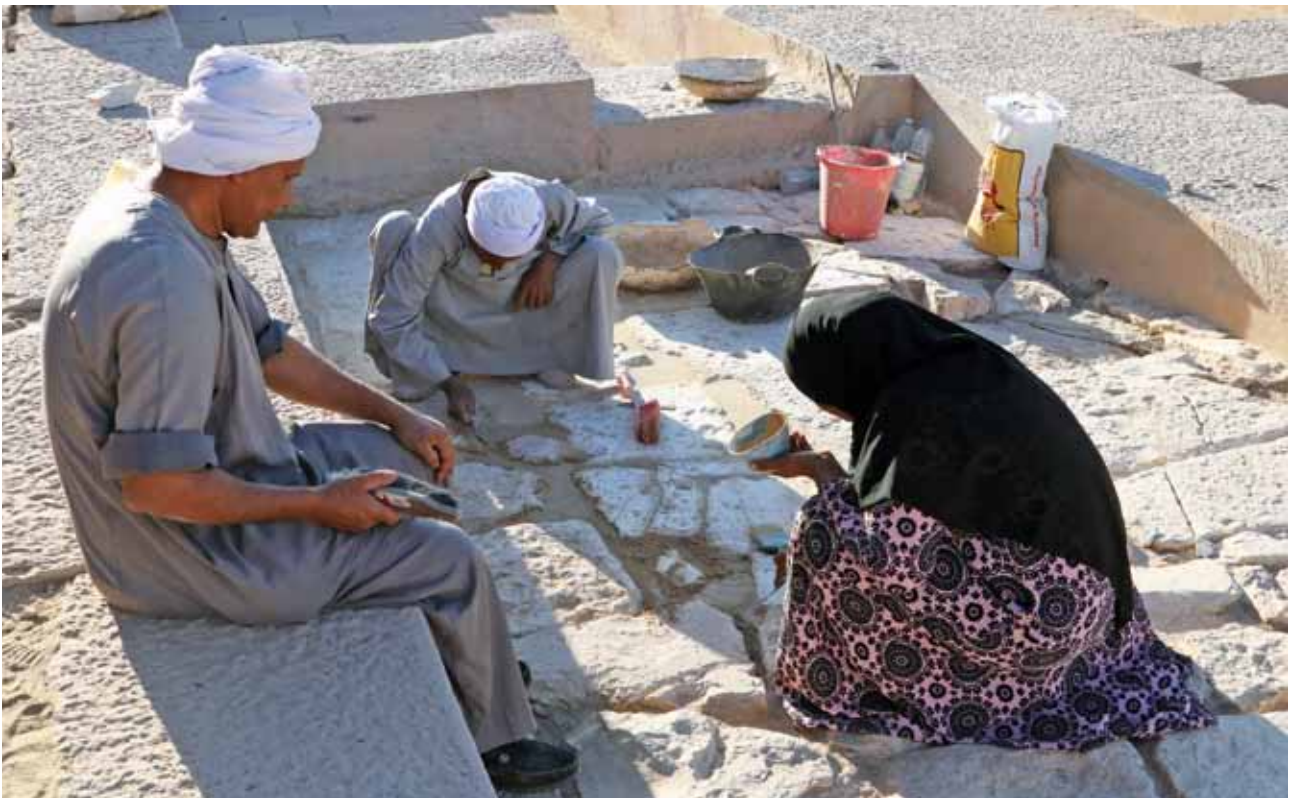
B.- RAMESSEUM. SECTEUR BCS. Restauration des dalles de pavement des salles du bas-côté sud du temple. (Cliché © Ahmed Abdel Hamid Ahmed).
